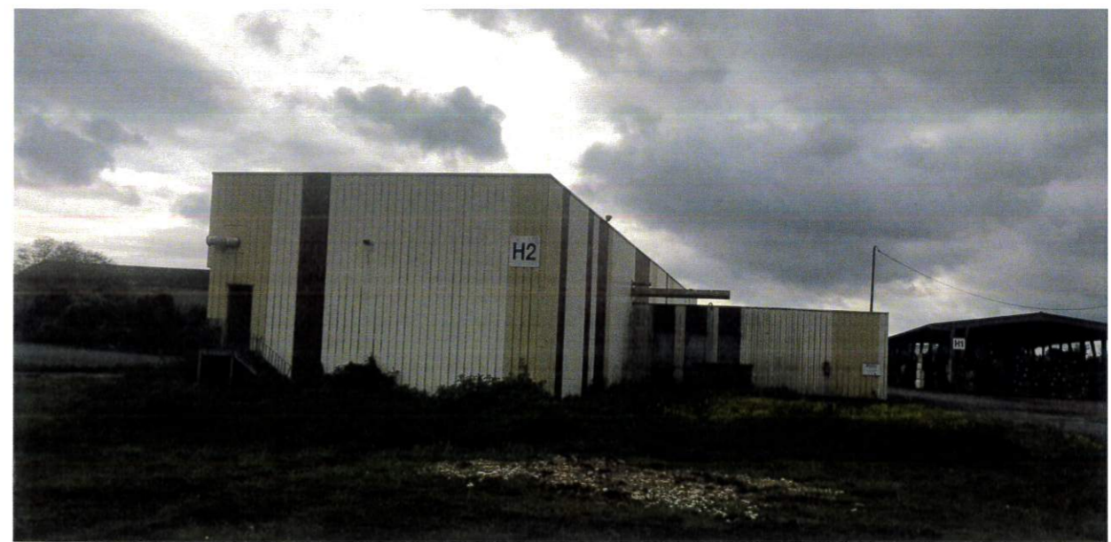
Photographie du bâtiment H2
