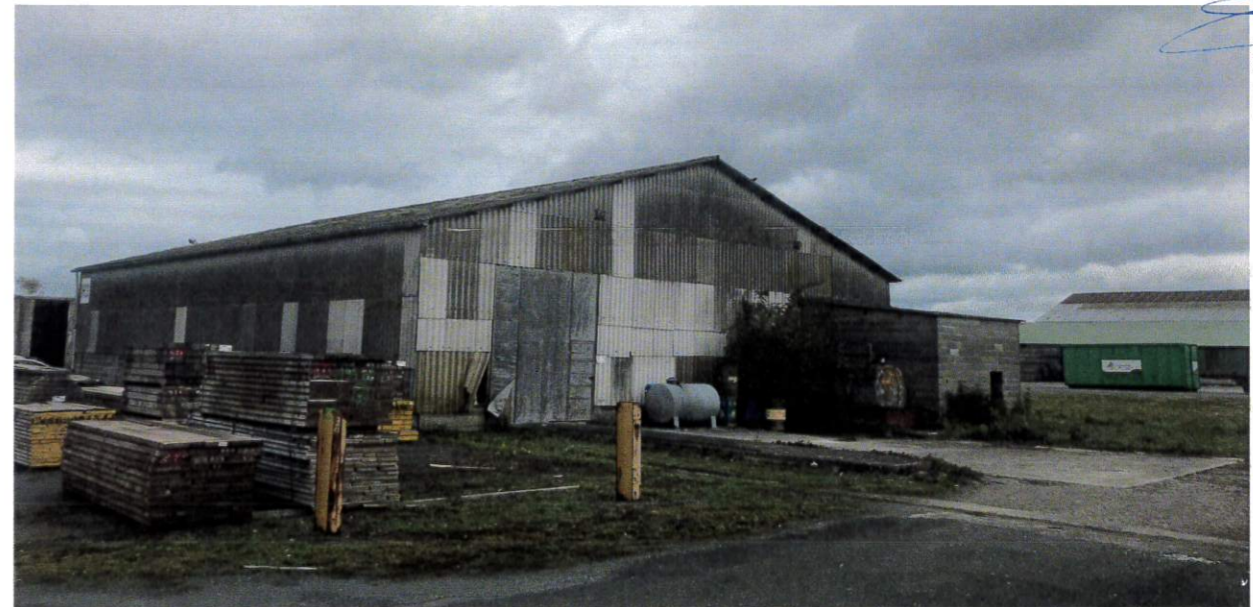
Photographie du bâtiment H3
